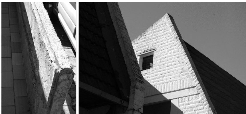
Imagen 2. Mosaico de imágenes mostrando la materialidad de la edificación
