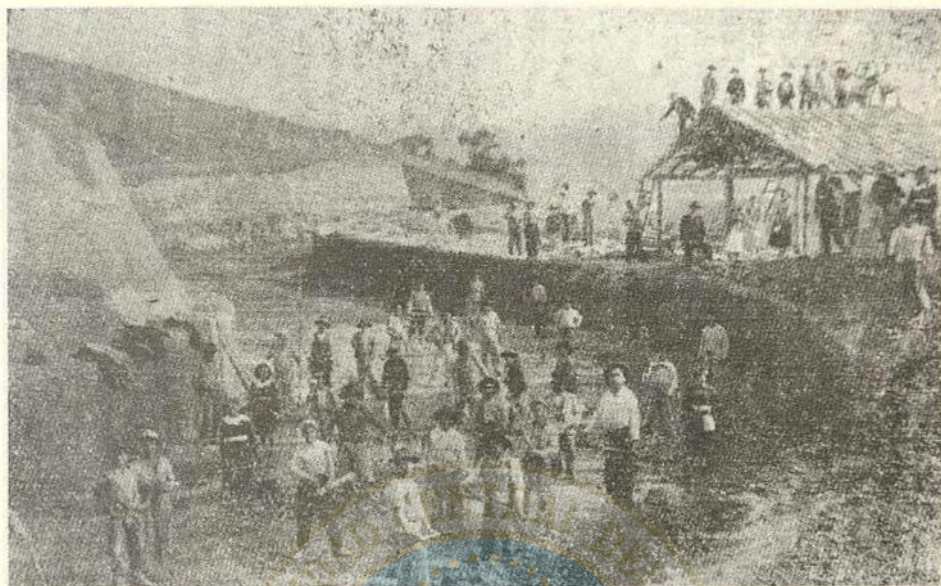
Vista parcial de una minga en el trabajo del reservorio en la obra hidráulica de la nueva planta de luz
