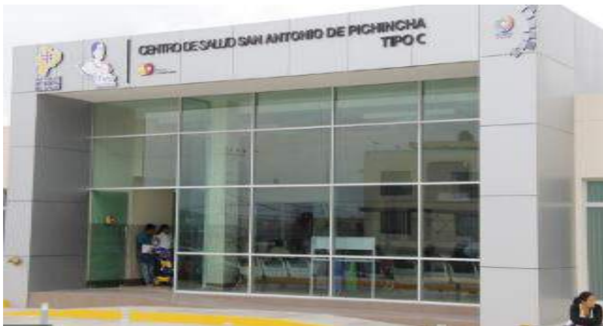
Fig. 6 - Centro de Salud San Antonio de Pichincha, 17D03 - MSP.
