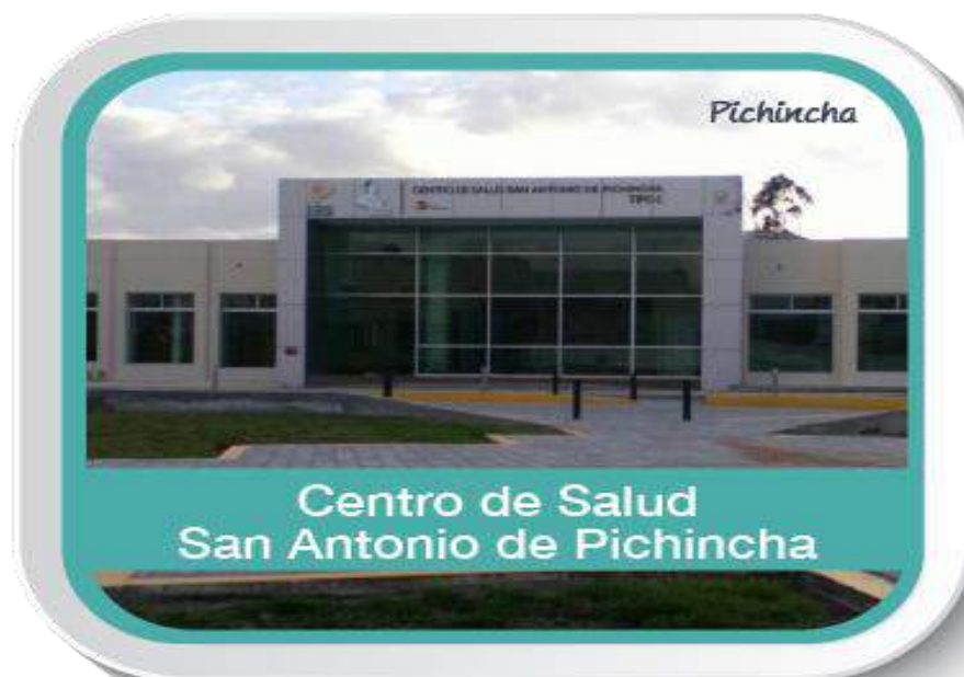
Figura 6 - Centro de Salud Tipo C, MSP, San Antonio de Pichincha
