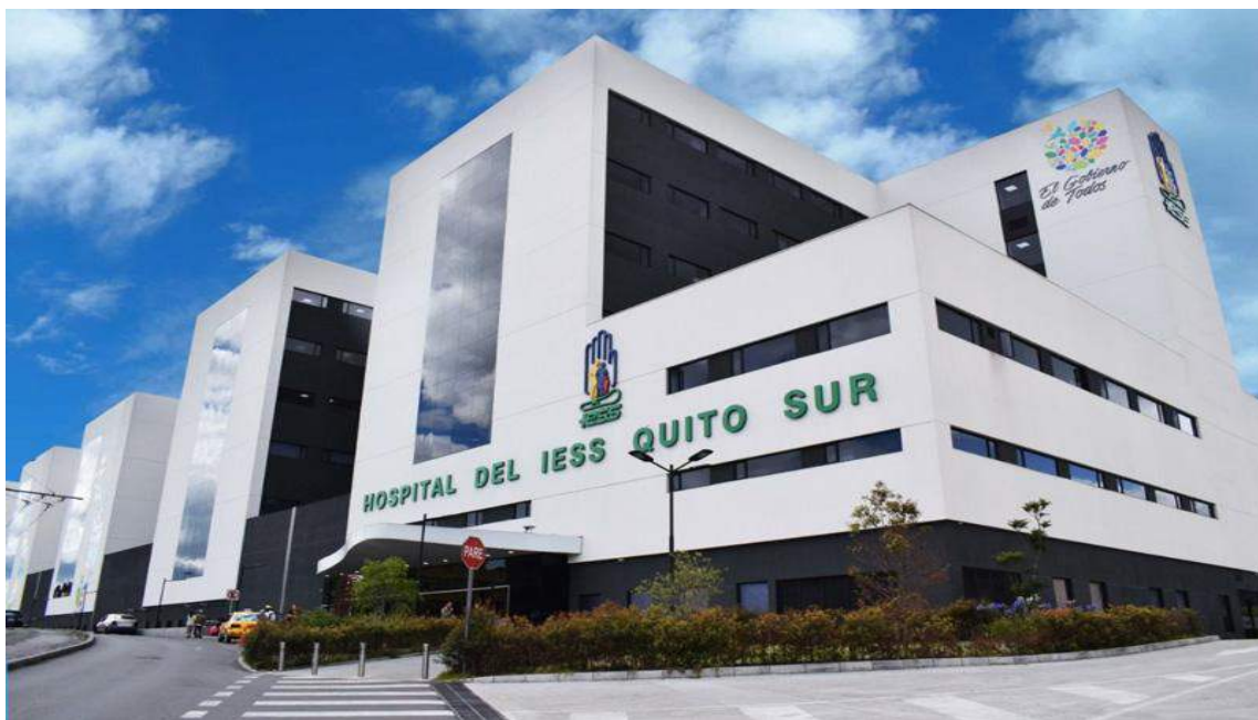
Fig. 2 - vista externa del Hospital del IESS Quito Sur
