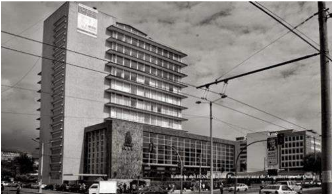
Figura 1 - Edificio de la Caja del Seguro, IESS, Avenida 10 de agosto, Quito
