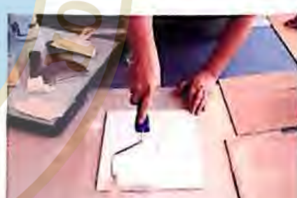
3. El yeso aplicado con rodillo rellenará parte de las vetas y creará una superficie lisa.
