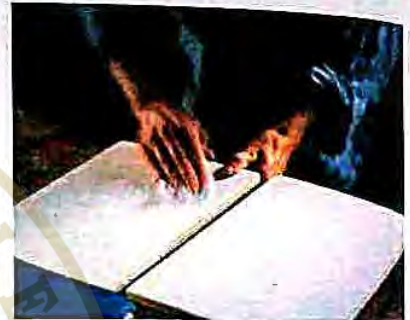
Bruña el panel con un paño de tela doblado ligeramente húmedo.
