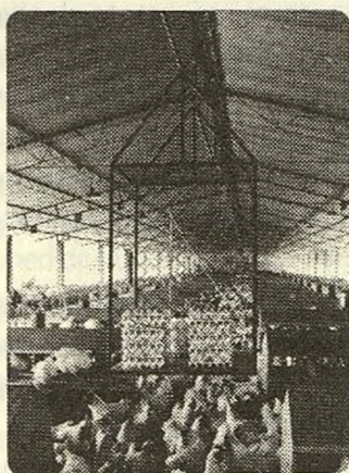
FIGURA 10.11. Monorriel suspendido del eje longitudinal del techo, para facilitar y agilizar la recolección de huevo fértil; este monorriel se empuja a lo largo de la caseta. Foto: Xóchitl Hernández Velasco
