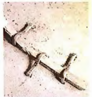
3. Debe quedar anclada sobre la base con clavos que, con un martillo, se doblan sobre el aluminio.
