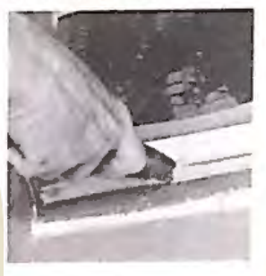
6. Cuando la resina está parcialmente endurecida, se recorta el borde con una cuchilla afilada para dejarlo neto y limpio.
