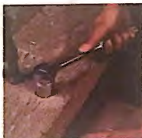
7. Se aprieta la tuerca con una llave tuerca, atornillándose hasta que quede dentro de la cavidad.
