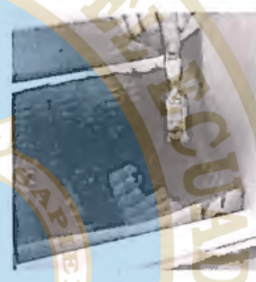
5. Se añade una capa de refuerzo de malla de papel desplegado, cortado a la medida de la estructura.
