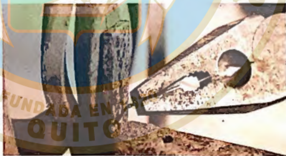
2. La armadura se sujeta fuertemente con alambre de acero al soporte de hierro.
