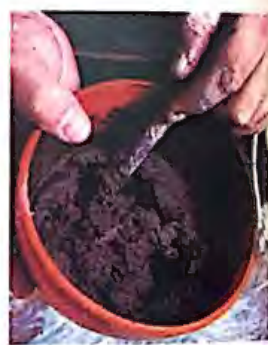
3. Se hace una mezcla de hormigón, bastante espesa, utilizando partes iguales de cemento y de arena blanca de cuarzo puro.
