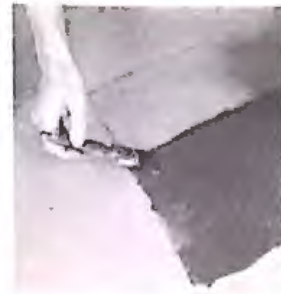
2. Se mezcla y se cataliza la resina para la capa de gel, que se aplica a pincel sobre el área marcada, dejándola que se endurezca.
