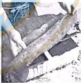
8. Se cubre el molde con sacos húmedos y se deja fraguar el hormigón.
