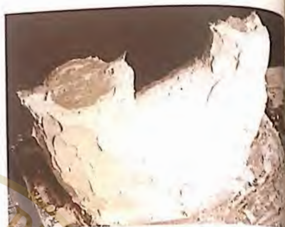
12. Se sigue poniendo yeso hasta formar una capa gruesa y uniforme. Debe ser particularmente fuerte en las juntas, contra la pared de arcilla.
