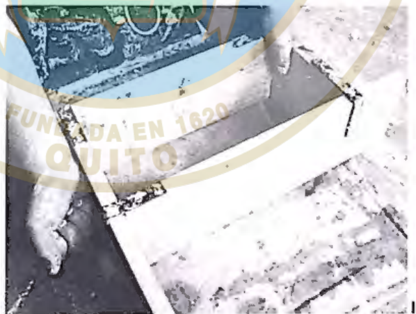
4. Se recubre por completo el cañamazo con yeso fresco y se sigue añadiendo éste hasta alcanzar la altura de las curvas interiores de la plantilla.
