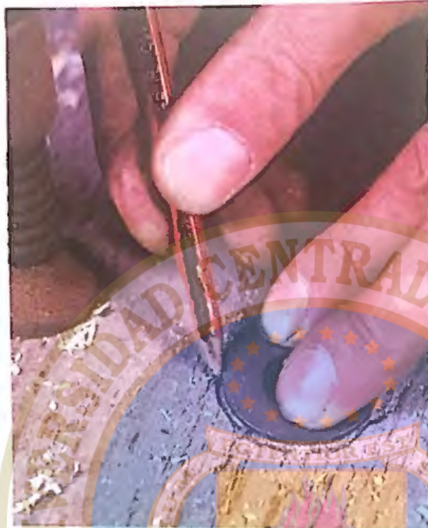
3. Los pernos tienen que ir avellanados. Se marca la circunferencia de la arandela del perno alrededor del agujero que se ha perforado
