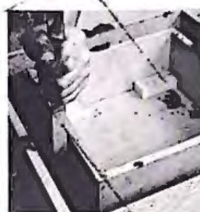
2. Se echa en el molde una capa de mezcla de hormigón espesa y se pudela con una vara o listón para que no se hagan burbujas de aire.
