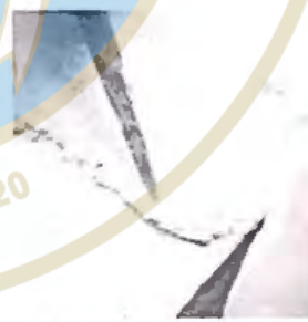
4. Se hace una entalladura en forma de V no muy profunda a lo largo de la superficie del yeso, centrada en la línea de unión.
