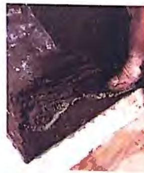
4. Se aplica a presión sobre la capa de cemento aluminoso una capa de 6 mm. de hormigón espeso, añadiendo más cantidad en los rincones.
