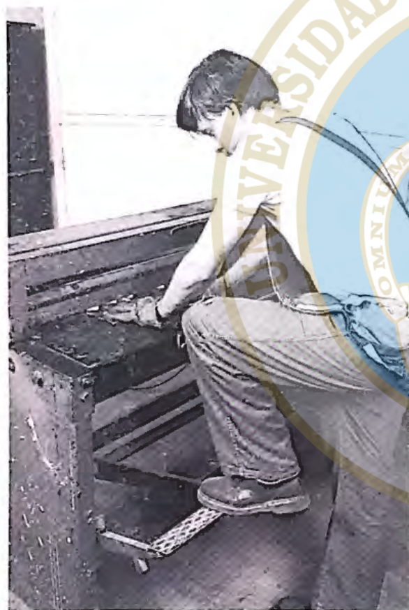
Corte y enderezamiento de una lata de hojalata 1. Se quita la parte de arriba y la de abajo y se corta a lo largo de un lado de la junta con una tijera de hojalatero.
