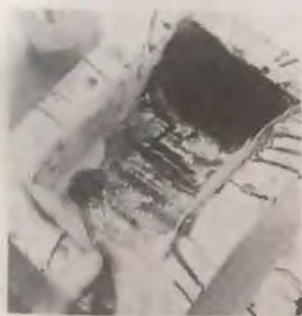
10. Se cataliza resina para estratificados y se aplica a pincel para impregnar el «mat». Se eliminan las burbujas de aire que pueda haber en la resina.
