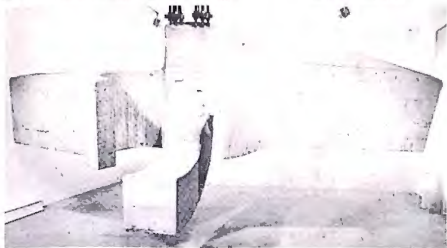
7. Se enrasa la parte superior del hormigón arrastrando sobre ella un listón de madera.
