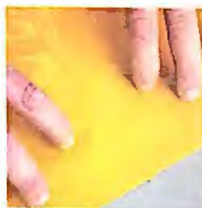
4. Se despliega el PVC y se alisa la junta. La eficacia del adhesivo y el doblez de la junta la hacen impermeable.
