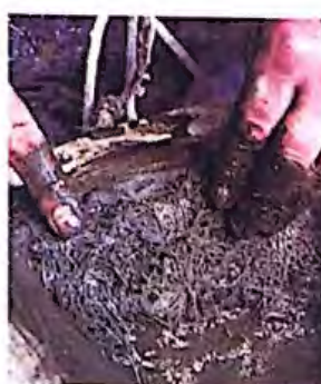
5. Aplicar una capa de refuerzo de «mat» de fibra de vidrio empapado en hormigón. Se cubre el molde con sacos húmedos y se deja fraguar.
