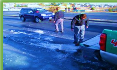
Figura 134. Eliminación de acumulación de hielo
