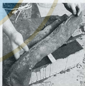
8. Se cubre el molde con sacos húmedos y se deja fraguar el hormigón.
