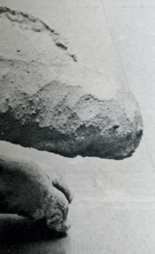
3. Se calza una de las secciones con los bordes de las juntas hacia arriba y en horizontal. Se echa mezcla de yeso fresca a lo largo de cada junta.
