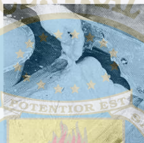
4. Se recubre por completo el cañamazo con yeso fresco y se sigue añadiendo éste hasta alcanzar la altura de las curvas interiores de la plantilla.
