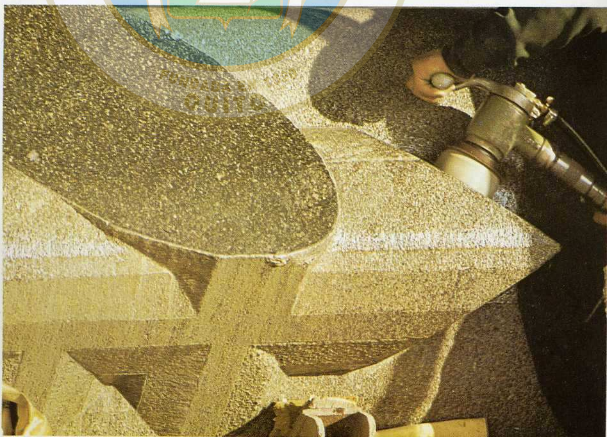
3. El acabado de la superficie se hace con piedras abrasivas, con las que puede trabajarse en húmedo y en seco.
