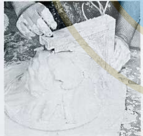
5. Sobre el cañamazo se pone una gruesa capa de yeso. Se gira la plantilla para que arrastre el yeso sobrante.
