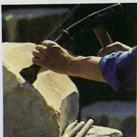
Talla en piedra 1. Se despejan primero amplias zonas de piedra para hacer la labra tosca de la forma. Con el cincel de desbastar se va cortando la piedra.
