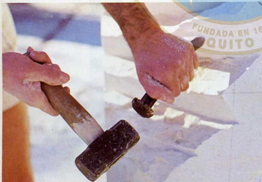
5. La cantidad de piedra que se separa del bloque puede variar si se altera el ángulo de incidencia del cincel. Después de este desbaste, los tasquiles pueden quitarse con un cepillo duro.
