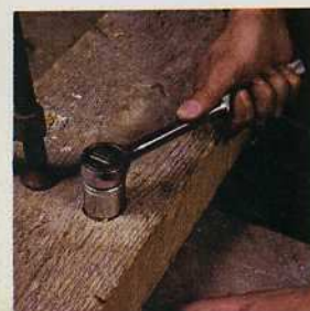
7. Se aprieta la tuerca con una llave tuerca, atornillándose hasta que quede dentro de la cavidad.
