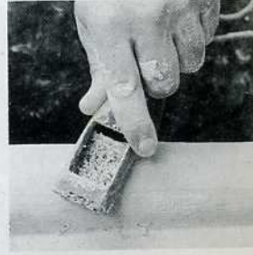
6. Una vez que el yeso de las juntas ha fraguado por completo, se pulimentan las líneas de junta con una escofina de hojas cambiables.
