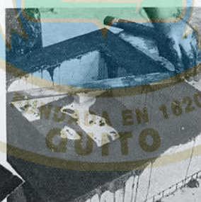
7. Se enrasa la parte superior del hormigón arrastrando sobre ella un listón de madera
