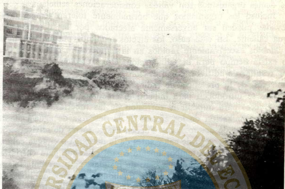
Fig. 9.2 Río coronado de vapor: el río Severn en Ironbridge, Inglaterra. Cuando fue tomada esta fotografía, la central eléctrica no disponía de torres de refrigeración y el agua de refrigeración iba a parar directamente al río produciendo este efecto (de la serie de diapositivas de Diana Wyllie, en Air Pollution ).
