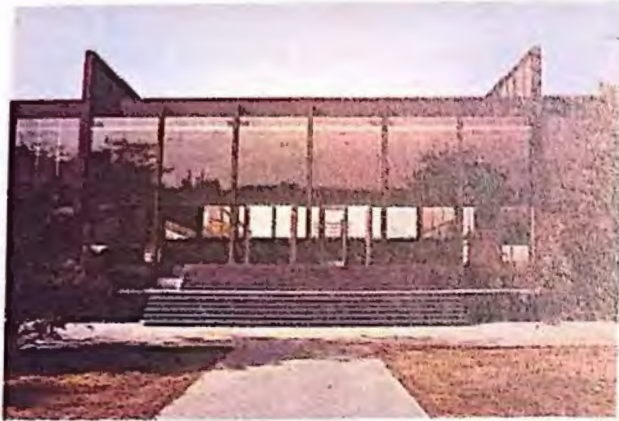
Fig. 77. L. Mies van der Rohe. Crown Hall. Chicago, 1952-56.
