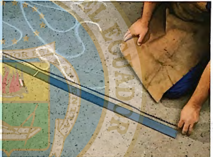
▲ 8. Se estira la cuerda y se marca con tiza la distancia sobre la pletina, en el punto por donde se iniciará el conformado de las curvas.
