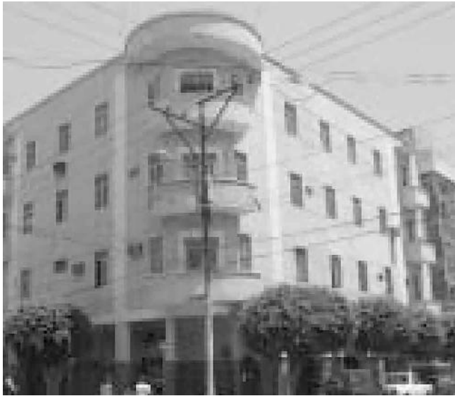
Edificio Elías Bucaram, Nacional. COMPTE, F. (2007). FRANCESCO MACCAFERRI Y LOS INICIOS DE LA ARQUITECTURA MODERNA EN GUAYAQUIL. Arquitectura y Urbanismo , XXVIII (3), 17.
