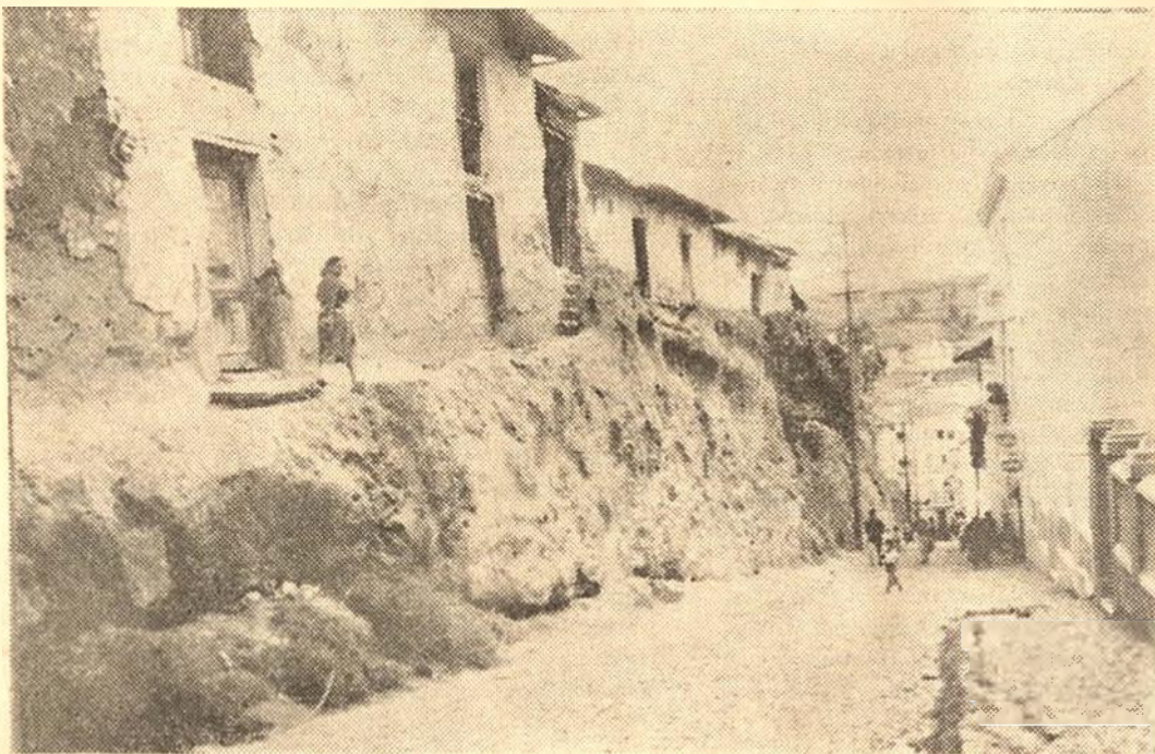
En pleno centro de Quito, encontramos el espectáculo de estas construcciones antihigiénicas y peligrosas para sus moradores.
