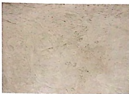
68. Emplastecido con estopa o estopado.
