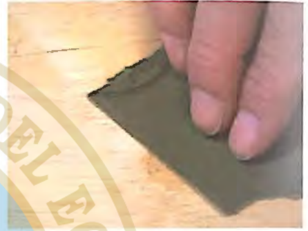
129. Lijado de las zonas emplastecidas.
