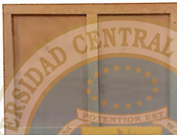
90. Refuerzo con un bastidor armillado con cruceta (para un tablero de contrachapado).
