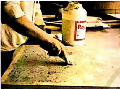
284. (a) Emplastecido general de grandes zonas con masilla.
