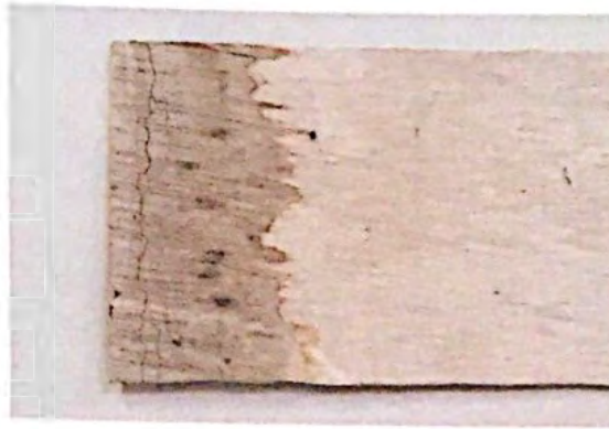
94. Daños ocasionados por la humedad en un tablero de contrachapado.
