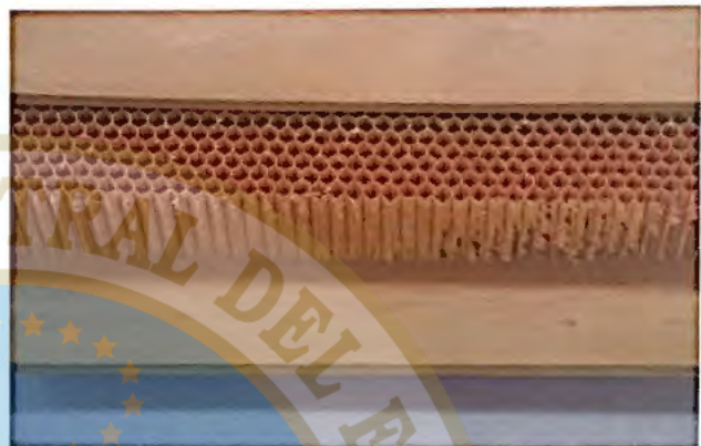
93. Detalle de refuerzo tipo sándwich hueco con estructura interna de celdillas de cartón tratadas con resina fenólica.
