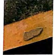
283. Detalle del emplastecido de pequeños defectos.
