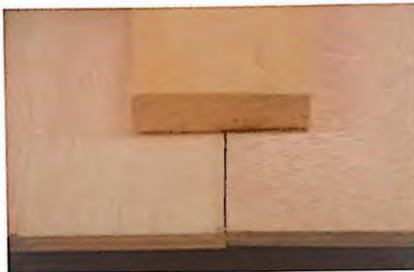
89. Ensamblaje de dos tablas de contrachapado reforzado con listones que sellan la unión.
