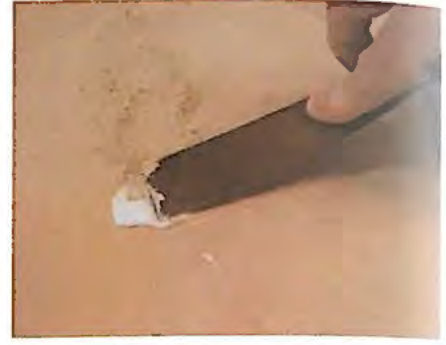
126. Amasado y obtención de la pasta de madera.
