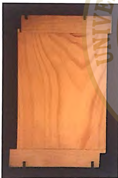
61. Refuerzo a testa con machihembrado.
