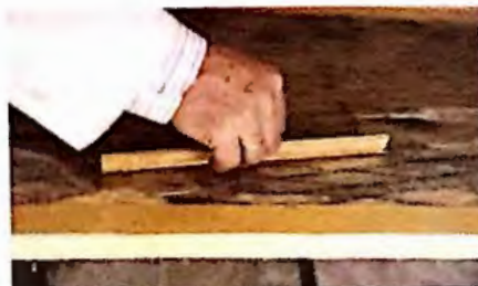
301. Extendido de la resina de poliéster sobre la capa receptora con la imprimadera.
