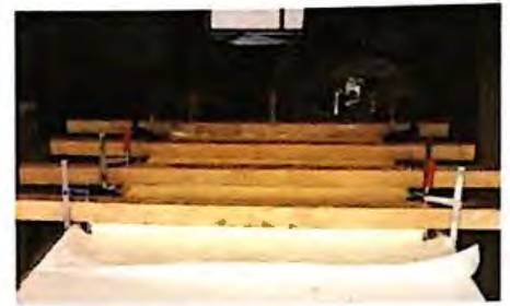
273. Prensado del tablero.
