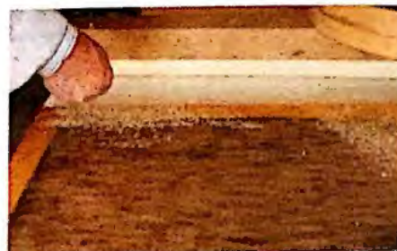
304. Aplicación mediante espolvoreado, y posterior prensado, de la arena sobre la resina de poliéster fresca.
