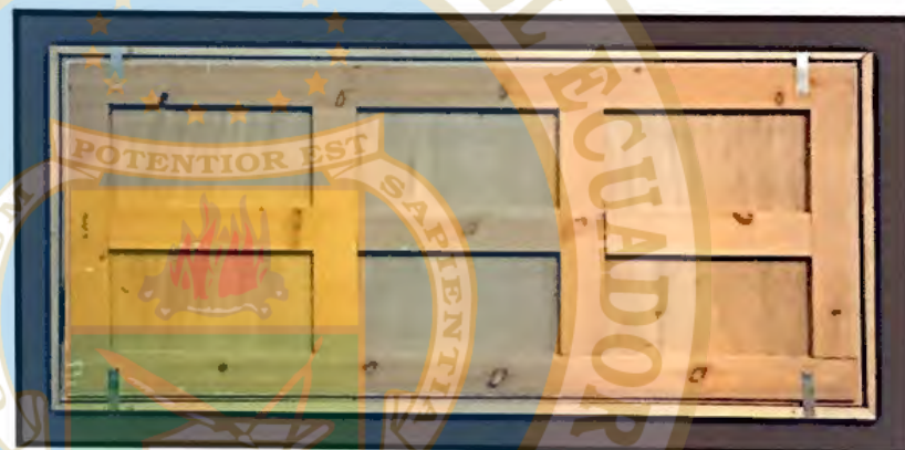
64. Refuerzo por bastidor armillado sujeto al marco mediante pletinas metálicas.
