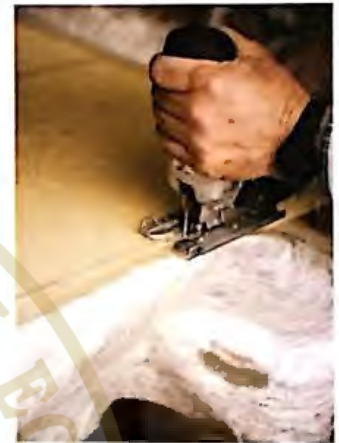
275. Corte con següeta eléctrica.
