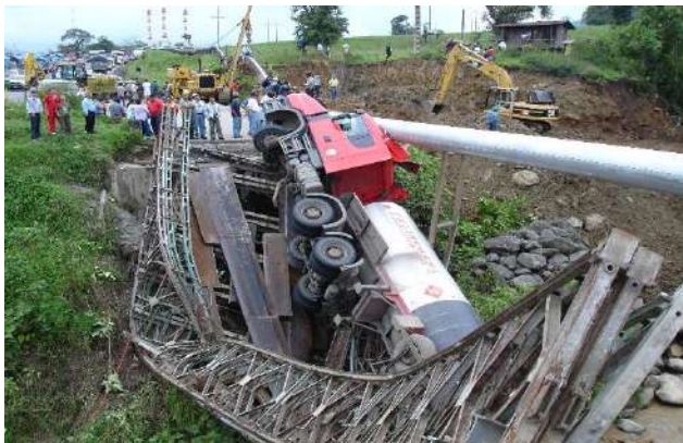
Figura 1. Accidente fortuito por desplome de un puente.
